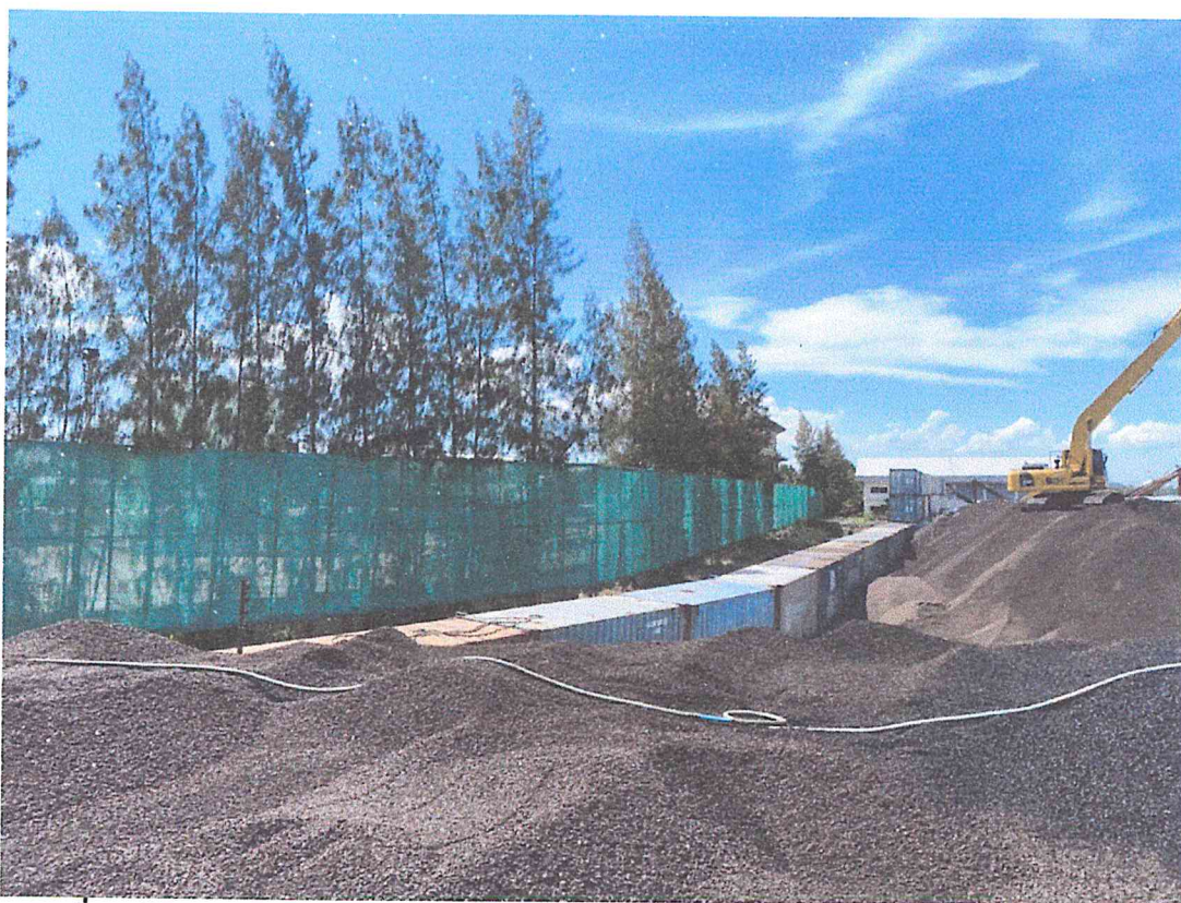
ภาพที่ 7 มีการชิงสแลนและปลูกต้นไม้ตลอดแนวเพื่อเป็นการดักจับฝุ่นละออง
