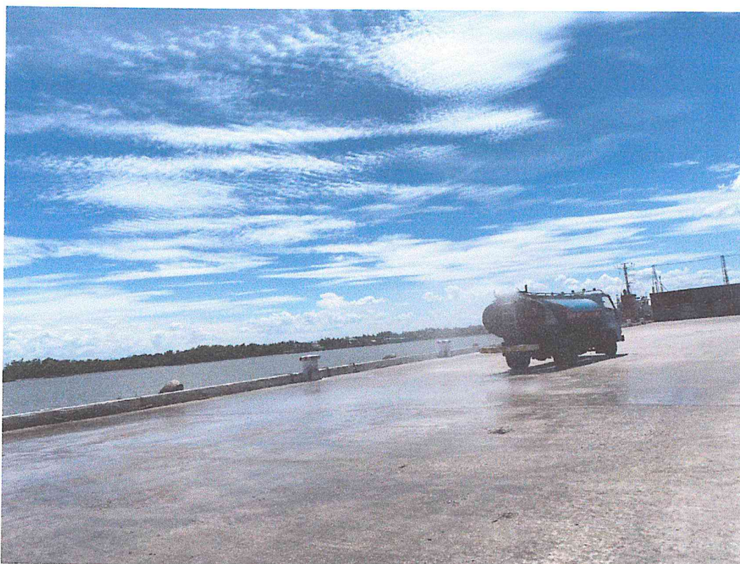
ภาพที่ 3 ใช้รถน้ำปล่อยสเปรย์น้ำลงบนพื้นถนนบริเวณท่าเทียบเรือเพื่อลดการฟุ้งกระจายของฝุ่นละออง ทุก 1-2 ชั่วโมง/ครั้ง
